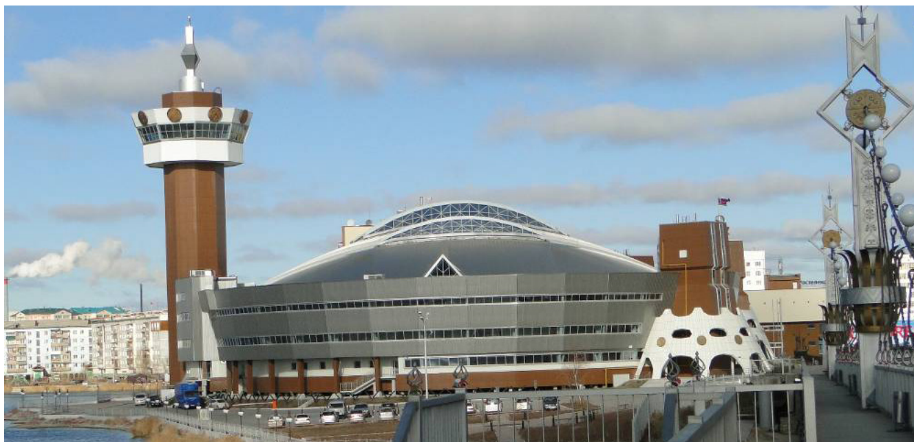
Рис. 1. Универсальный спорткомплекс «Триумф» г. Якутск
