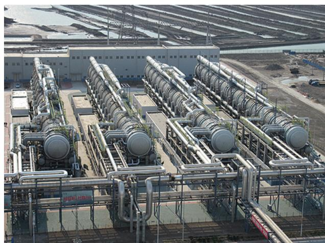
Рис. 5. Комплекс вакуумно — испарительных ледогенераторов ECO-VIM
