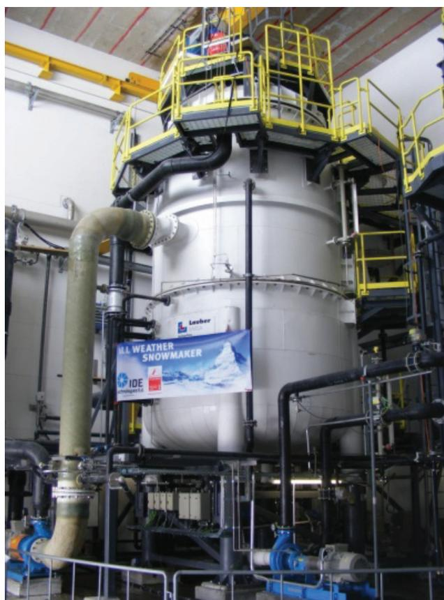
Рис. 6. Вакуумно-испарительные установки IDE All Weather Snowmaker
